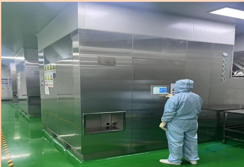
清洗工序D级洁净区清洗
